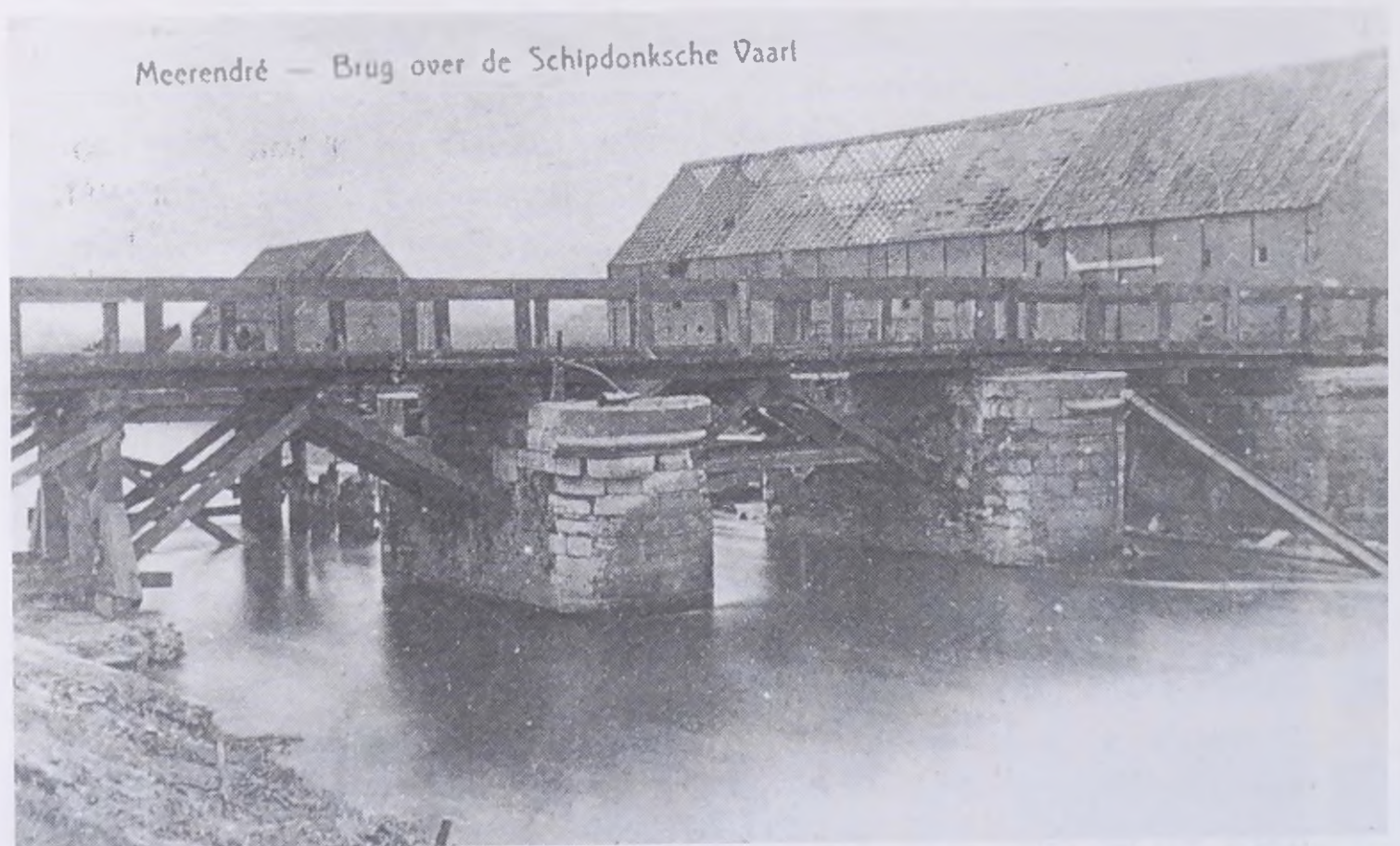
De houten noodbrug over het Schipdonkkanaal te Merendree in 1918. De foto werd gemaakt vanaf de westelijke oever met zicht op Merendree. (Verzameling Het Land van Nevele)
